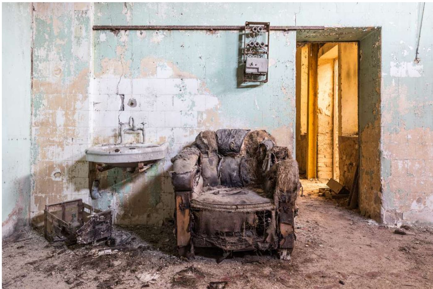
Usine tout en un – Pile
